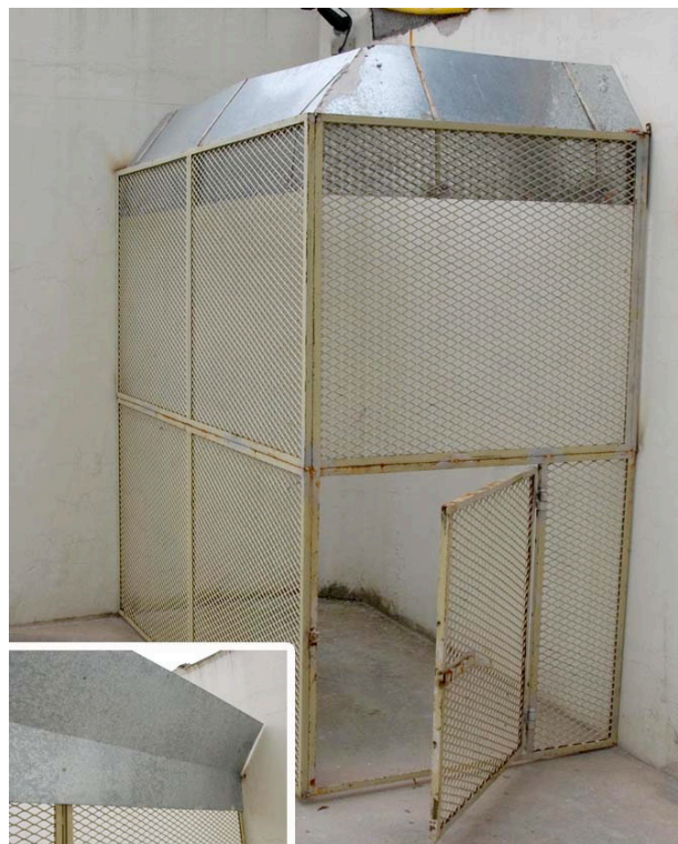
Figura 4 - Vista geral do cercado construído no canto da área experimental e no canto direito inferior, vista interna da chapa galvanizada soldada na parte superior da tela
